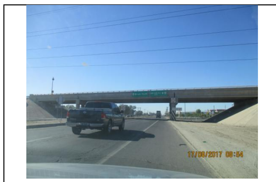
Intersección de la carretera Mexicali - San Felipe y libramiento Mexicali – La Rosita
