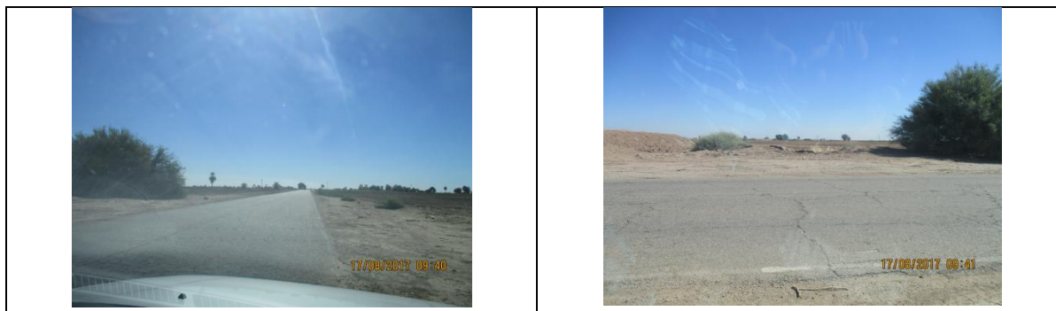
Puntos ubicados sobre la carretera al Ejido Zacamoto
