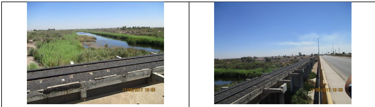
Puente del ferrocarril de Las Casetas.
