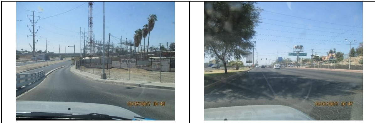
Calzada de los Presidentes o Río Nuevo y sus entronques con Av. Internacional y calzada Independencia.
