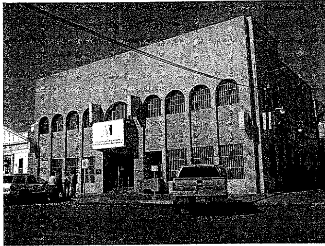
VISTA FRONTAL DEL EDIFICIO:
